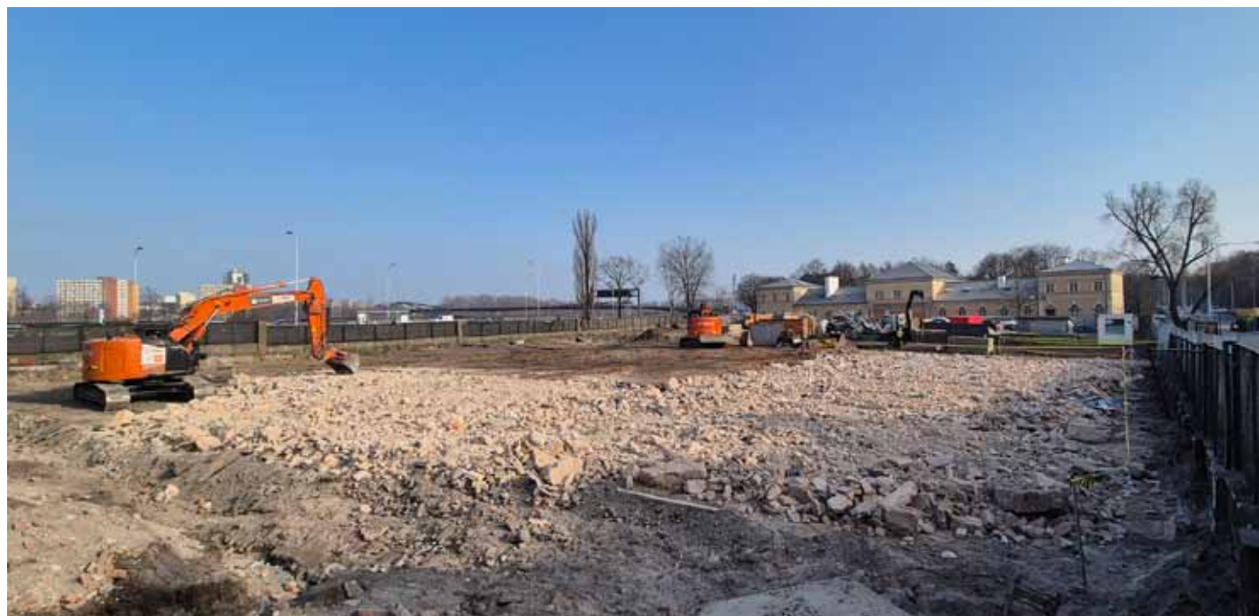
fot. Aleksandra Sheybal, plac budowy od strony ulicy Nowy Jazd
