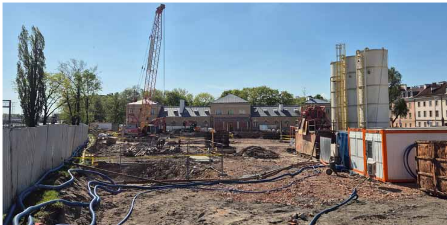
Plac budowy przy Bednarskiej, fot. A. Sheybal
