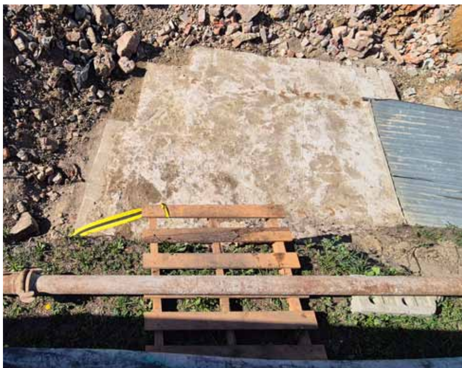
Odsłonięta betonowa płyta zakrywająca (prawdopodobnie) wlot do szybu metra z lat 50-tych, fot. A. Sheybal
